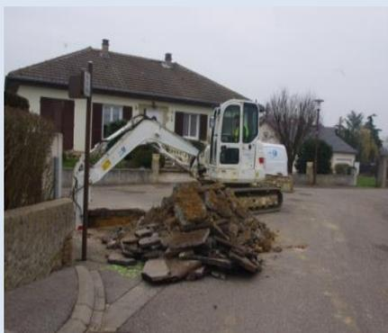
Remplacement des canalisations d'assainissement rue des Roses travaux réalisés par **HAGANIS**
