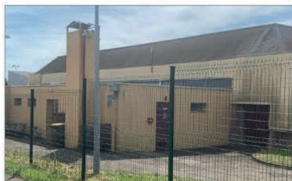
Des travaux sont prévus à salle polyvalente : la façade, le faux plafond et la toiture.
