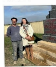
Damien Lambert, tailleur de pierre, a été chargé de ce chantier.
