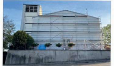
Ce chantier de rénovation coûtera 7 279 € à la commune.
