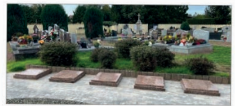
Les travaux d'installation des cinq nouvelles caves urnes sont terminés.
